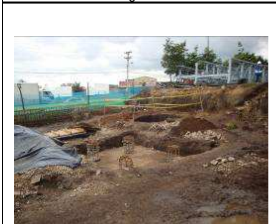
Costado Oriental –Estado a 13 de julio de 2010
