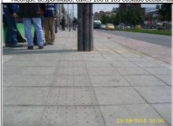
Se observa un poste como obstáculo en el camino de las losetas táctil alerta (no corresponde a los diseños establecidos), calles 106 a 109 costado occidental.
