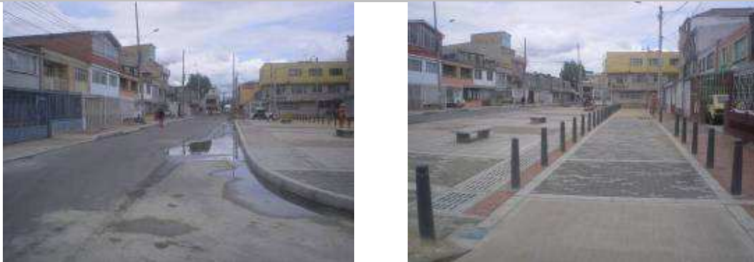
Presenta apozamiento, faltan remates y demarcación Ejecución 2010
