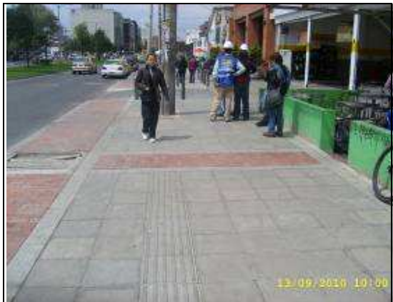
Se observa un poste como obstáculo en el camino de las losetas táctil guía, calles 106 a 109 costado occidental.
