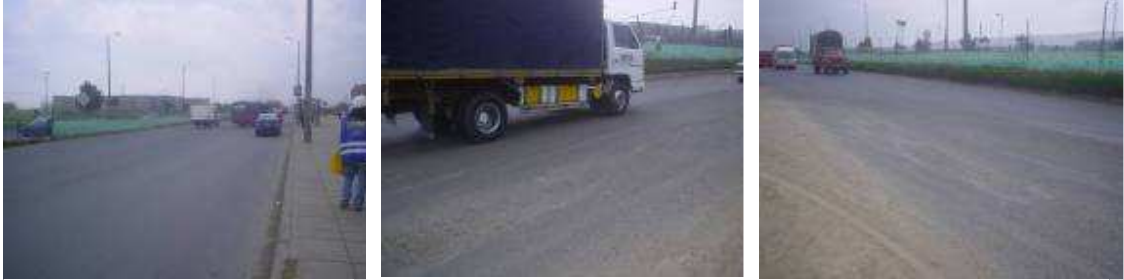
Terminada sin demarcar
