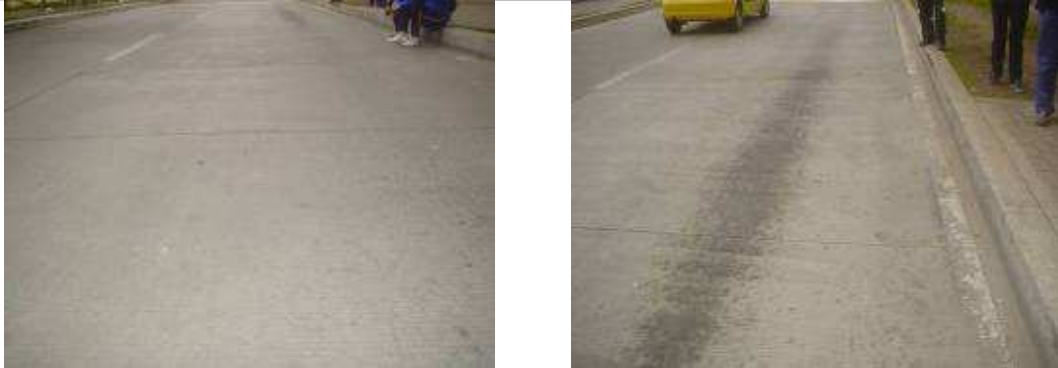
Desgaste prematuro por frenada de alimentadores transmilenio
