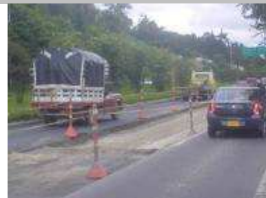
Frente 2 en ejecución
