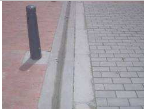
Espacio público y vía en adoquín terminados Presenta dilatación entre canaleta y viga de confinamiento
