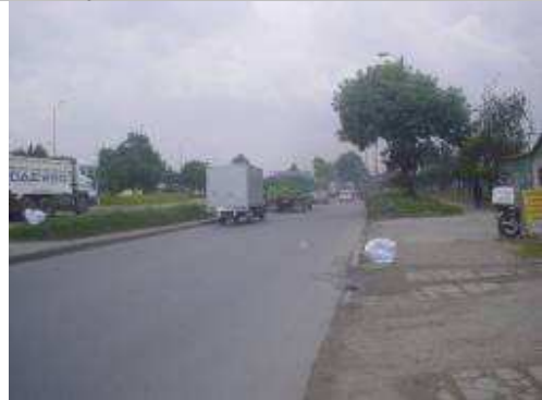
Calzada lenta oriental terminada – Falta demarcación
