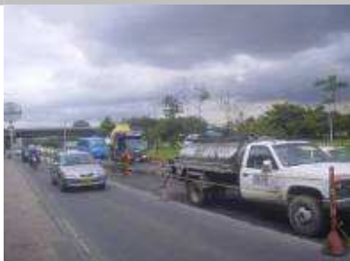
Frente 1 en ejecución
