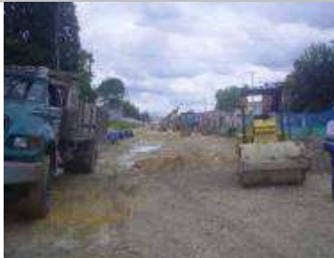
Calzada sur – Colocación de base estructural En ejecución - Atrasada
