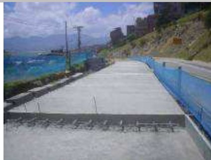
Rehabilitación en concreto LAGUNA 1, 2 Y 3
