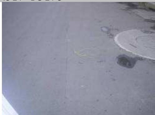
Falta demarcación – fisura cerca al pozo
