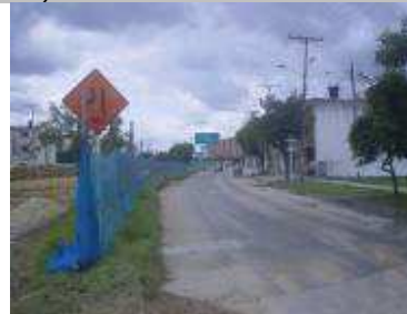
Calzada norte – A rehabilitar
